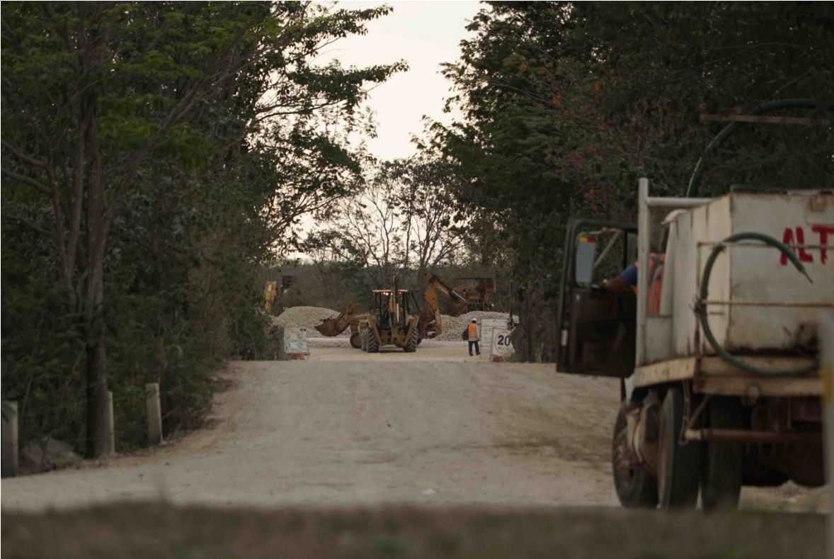
Trabajos de construcción del Tren Maya en el tramo 2 a la altura del poblado de Pomuch, Hecelchakán, Campeche. Robin Canul.
