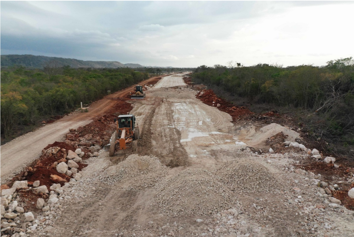
Construcción del Tren Maya en Maxcanú, Yucatán. Foto: Robin Canul.
